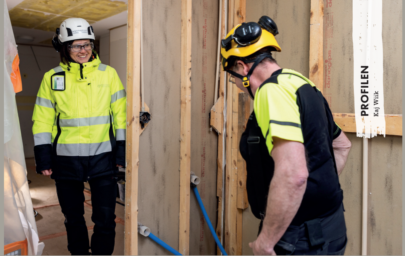
1 Arbetsledaren Pia Gammal och Kaj Wiik inne i ett egnahemshus i Gerby som totalrenoveras.
